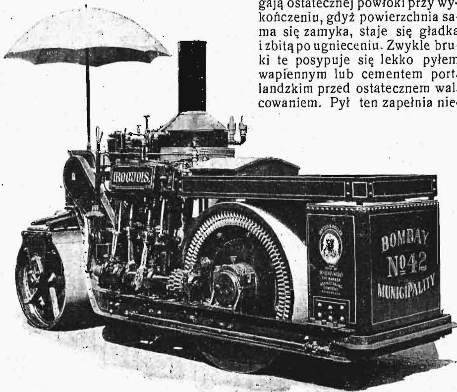
Rys. 43 Walec podwójny używany do walcowania nawierzchni asfaltowej.
