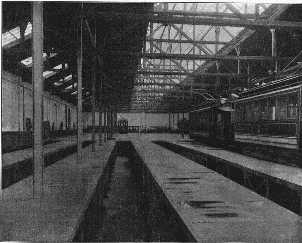
Rys. 16. Wnętrze remizy po wykończeniu.
