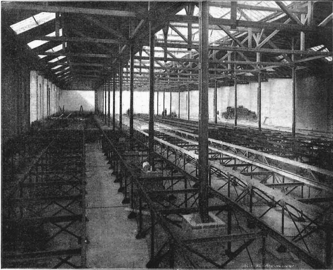
Rys. 15. Wnętrze remizy przed wykończeniem.
