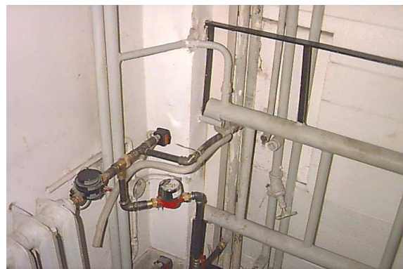
Rys. 56. Grzejnik pionu badawczego wraz z oprzyrządowaniem.
