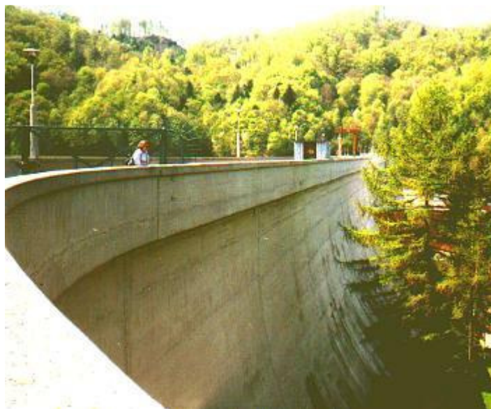
Fot. 10.0.1. Zapora wodna na Dunajcu w Rożnowie.
