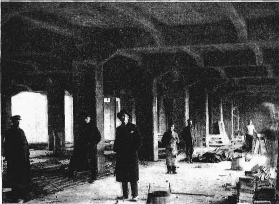
Strop nad 1-ym piętrzem po rozdeskowaniu.
