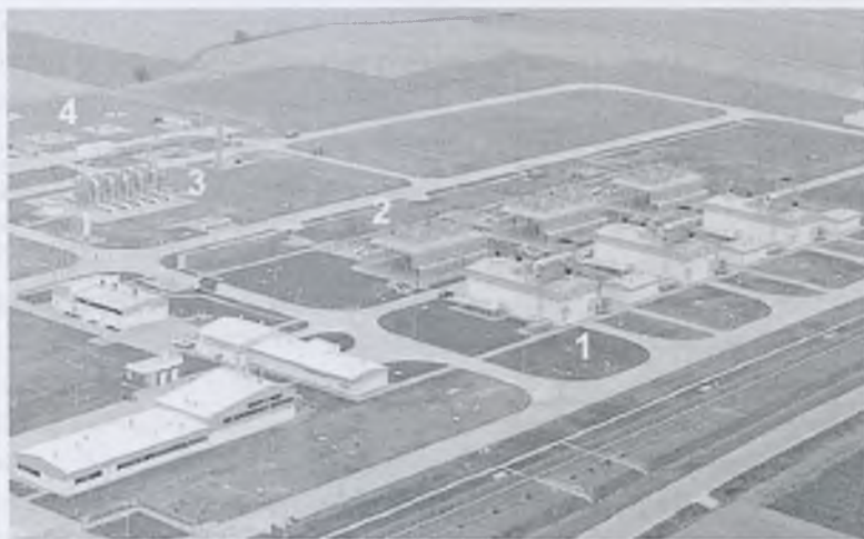
Rys. 2.1. Widok stacji przetłoczonej gazu: 1 – budynki turbokompresorów, 2 – chłodnice gazu, 3 – filtry i odwadniacze gazu, 4 – układy zaporowe; źródło: Gerwatowski (2006)
