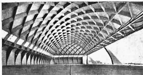
Hangar żelbetowy w Italii. Inż. P. L. Nervi,
