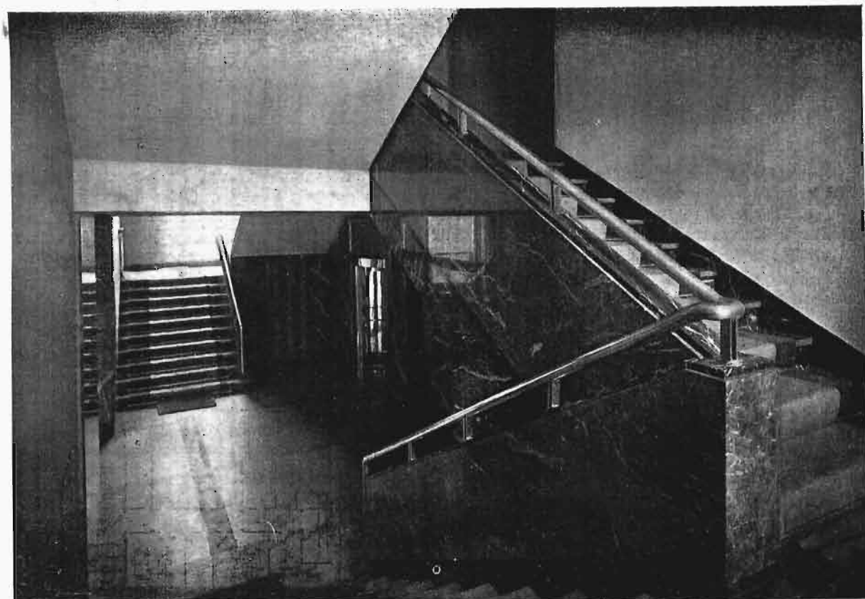
Fragment klatki schodowej.
