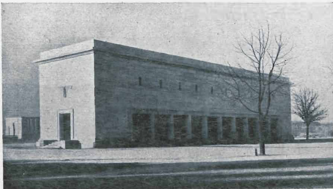
Rys. 24. Arch. Albert Speer: Stacja transformatorowa na „Reichsparteitaggelände” w Norymberdze, 1934. pg. Baugilde
