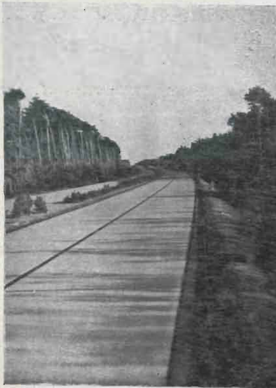
Rys. 19. Autostrada Frankfurt n. M. - Darmstadt. pg. die Strasse
