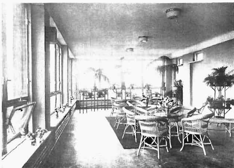
Leżalnia — w n e t r z e. Okna żelazne specjalnej kon- strukcji, całkowicie otwierane.
