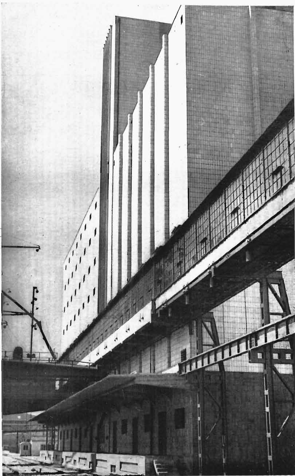
Widok elewatora od strony morza
