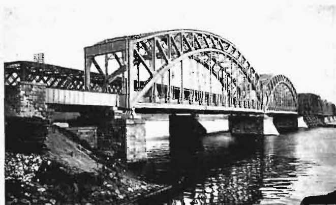
Most kolejowy na Dźwinie w Rydze
