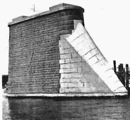
Filar rzeczny mostu drogowego na Wiśle w Puławach
