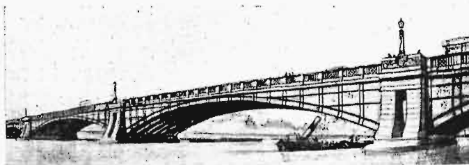
Lambeth Bridge na Tamizie w Londynie
