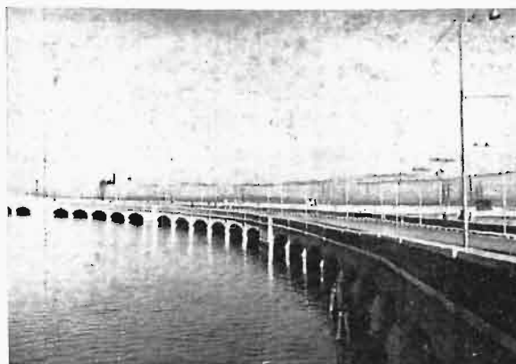
Autostrada Padwa — Wenecja biegnąca mostem przez laguny
