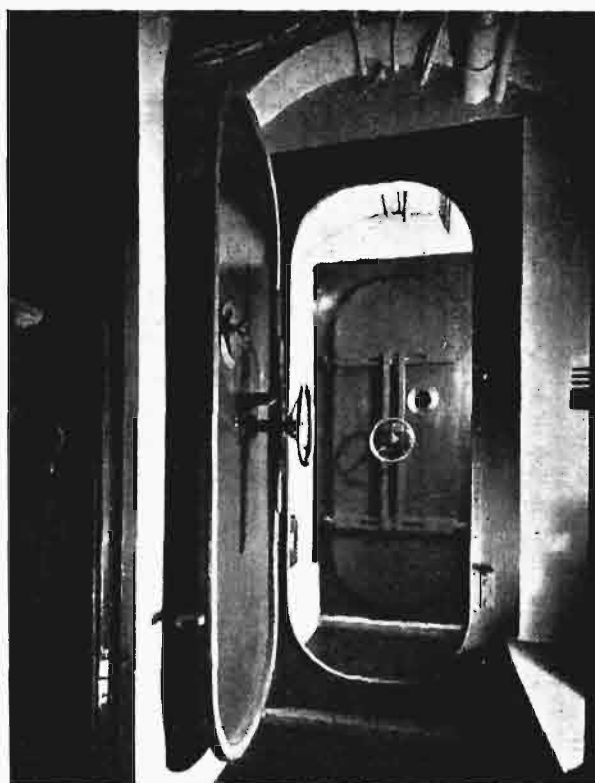
DRZWI SZCZELNE NA GAZ I ODPORNE NA ODLAMKI — wyprodukowane przez firmę Carrier-Engineering (Ameryka).
