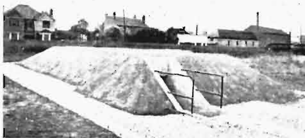
WEJŚCIE DO SCHRONU POWIERZCHNIOWEGO W POBLIŻU LONDYNU.
