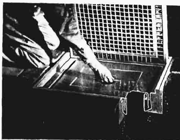
POZIOME WYJŚCIE ZAPASOWE (w nagłym wypadku).
