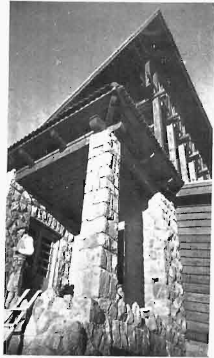
FRAGMENT STACJI KOLEJKI NA GUBALÓWCE,
