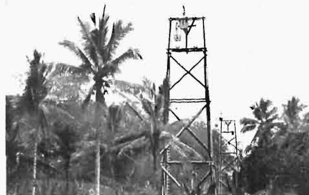
Kolej towarowa w Indiach Wschodnich dług. 10 km.
