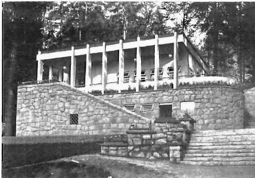
DOLNA STACJA KOLEJKI GÓRSKIEJ W KRYNICY,
