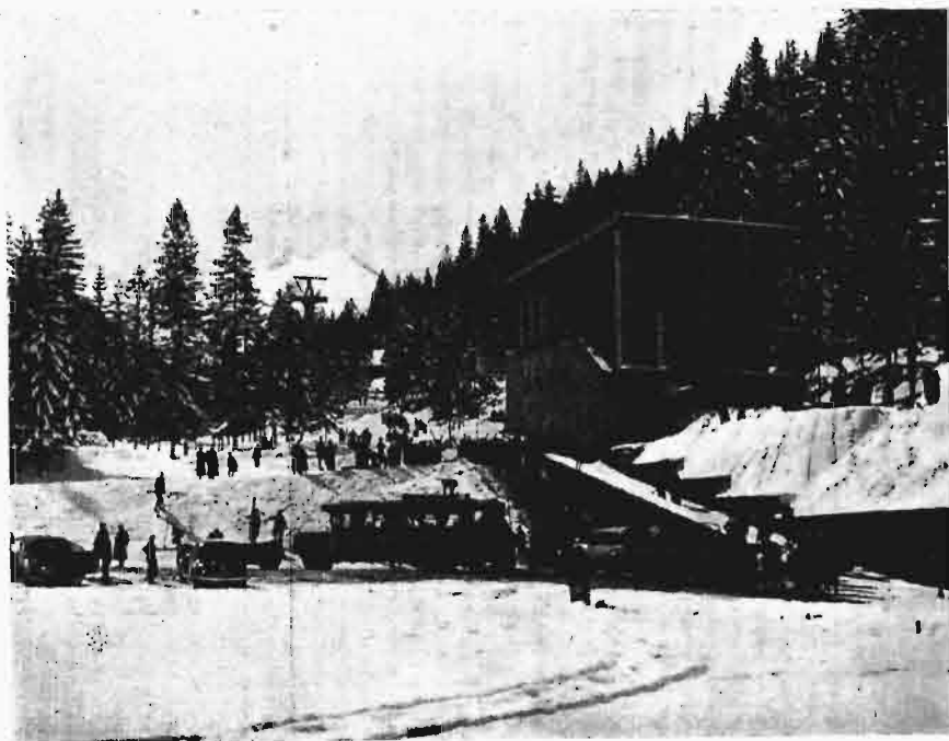
DOLNA STACJA KOLEI LINOWEJ W KUŹNICACH, proj.: inż. arch., inż. arch. A. i A. Kodelscy.
