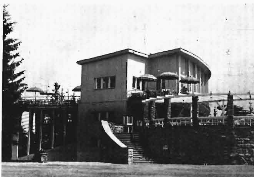
GÓRNA STACJA KOLEJKI NA GÓRZE PARKOWEJ W KRYNICY. NA PRAWO TARAS KAWIARNI. proj.: inż. arch., inż. arch. A. Kodelski, J. Skolimowski.
