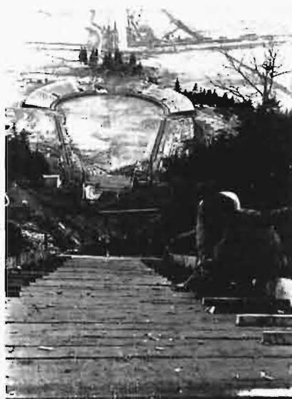
SKOCZNIA I STADION W BUDOWIE.
