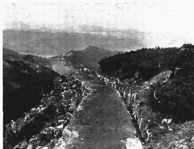
ŚCIEŻKA W BUDOWIE. fot. W. Ostrowski.
