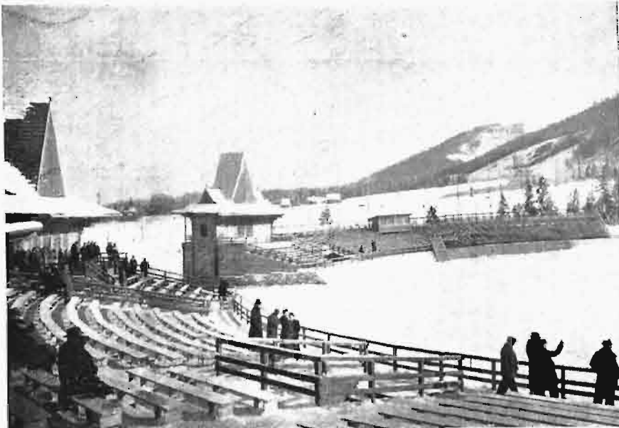
FRAGMENT STADIONU NARCIARSKIEGO W ZAKOPANEM.
