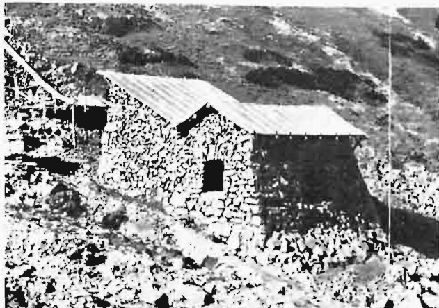
STACJA DOLNA WYCIĄGU SANIOWEGO NA KASPROWYM.
