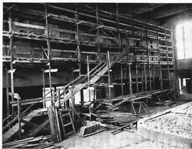
MONTAŻ PŁASKORZEŻB J. KLUKOWSKIEGO W HALI PRZYJAZDOWEJ.
