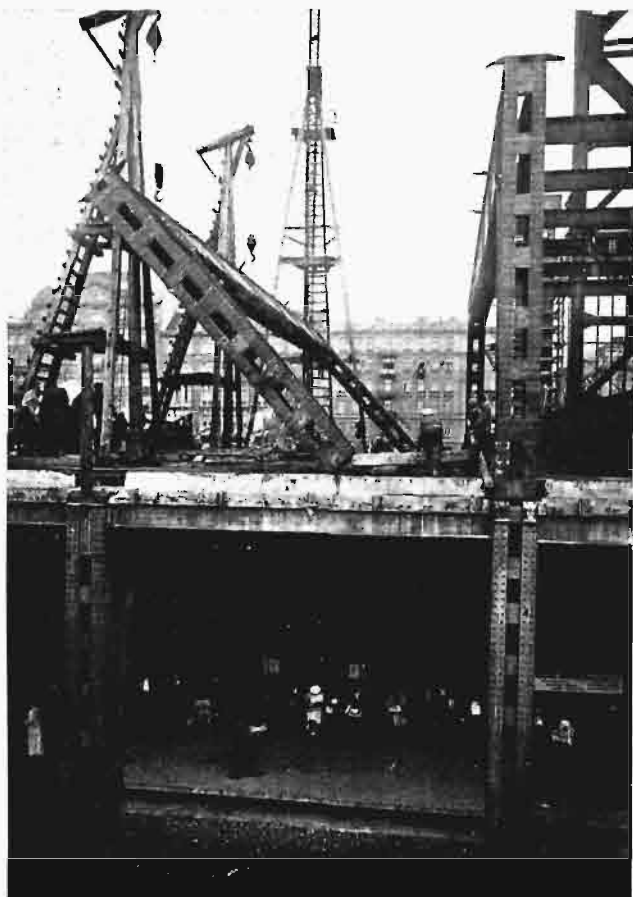
MONTAŻ KONSTRUKCJI W CZASIE UŻYTKOWANIA
