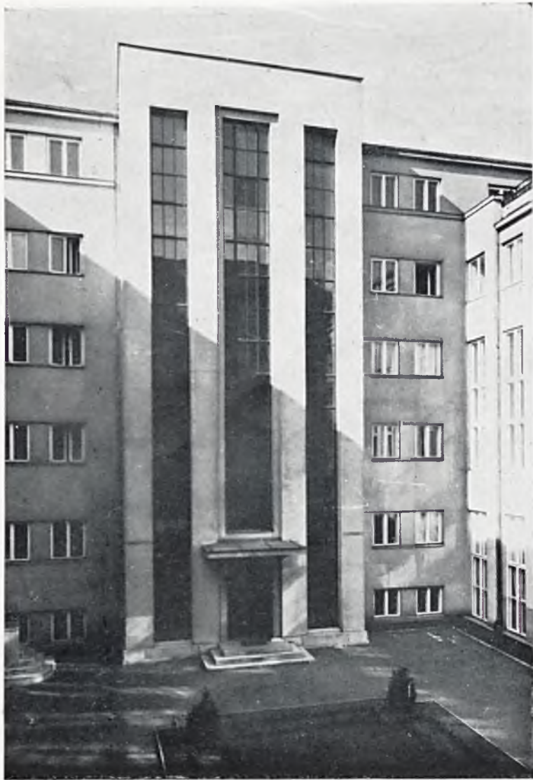
Klatka schodowa bursy.
