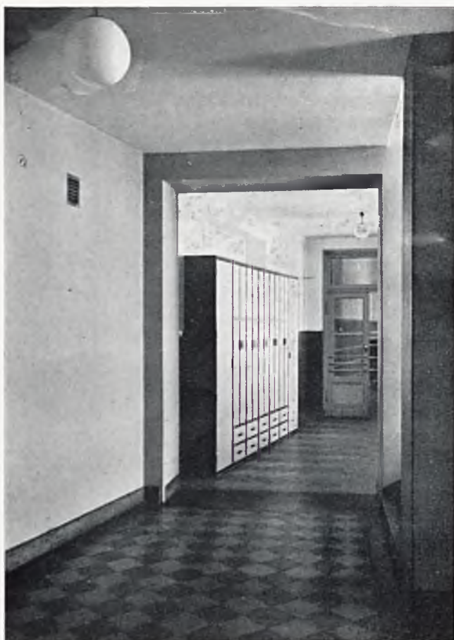
Korytarz z szafami dla mieszkańców bursy.
