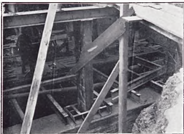
Fig. 33. — Pilier en sous-sol du bâtiment B. Słup w piwnicy budynku B.
