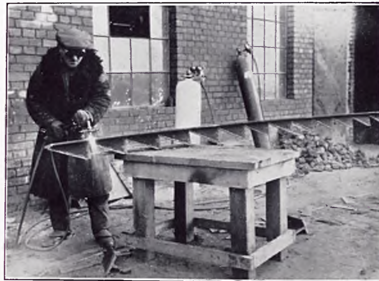
Fig. 20.— Découpage des consoles au chalumeau.
