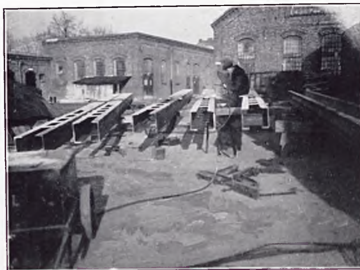
Fig. 15. — Soudure de la colonne.
