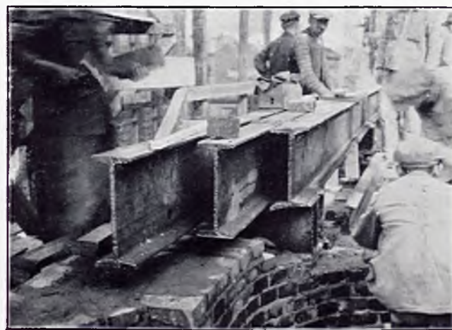
Fig. 45. — Découpage d'une poutre pour aménager la grande entrée. Obcinanie belek podciągu w okolicy głównego wejścia.
