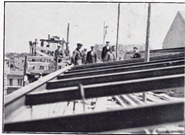
Fig. 32 Construction du toit de la partie A. Dach spawany oficyny A., wykonany z dwuteowników.
