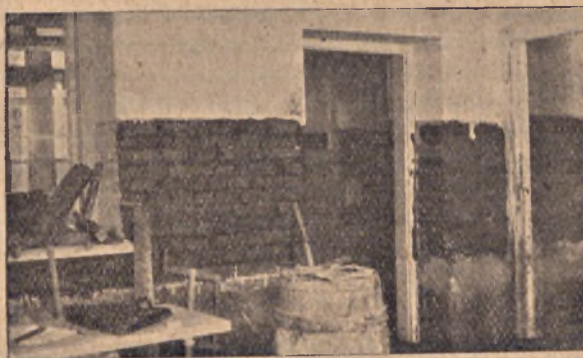
Sierociniec im. Marsz. Piłsudskiego w Warszawie. Izolacja podłóg i ścian w suterenach materiałami CONCO.
