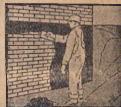
Izolację nakładamy na mur szpachlą.
