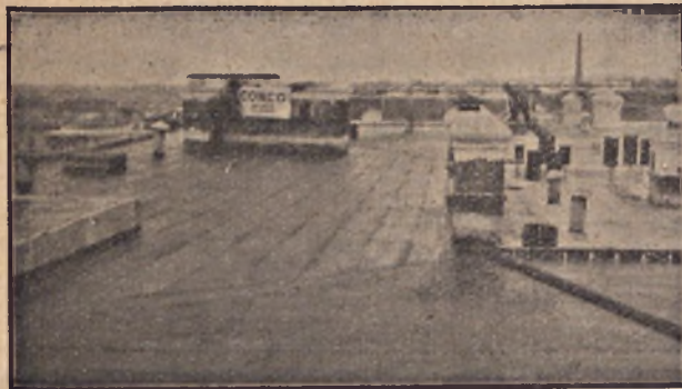
Magistrat m. Wiednia. Betonowy dach płaski pokryty materiałami izolac. CONCO
