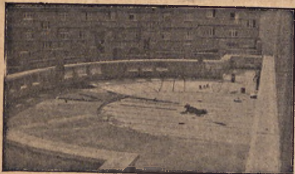
Taras zaizolowany materiałami izolacyjnymi CONCO
