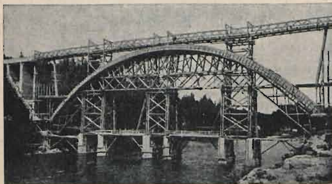
Rys. 6. Rusztowanie podczas betonowania łuku.
