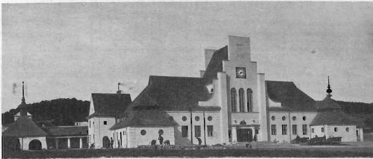
Rys. 1. Widok ogólny dworca od strony miasta.
