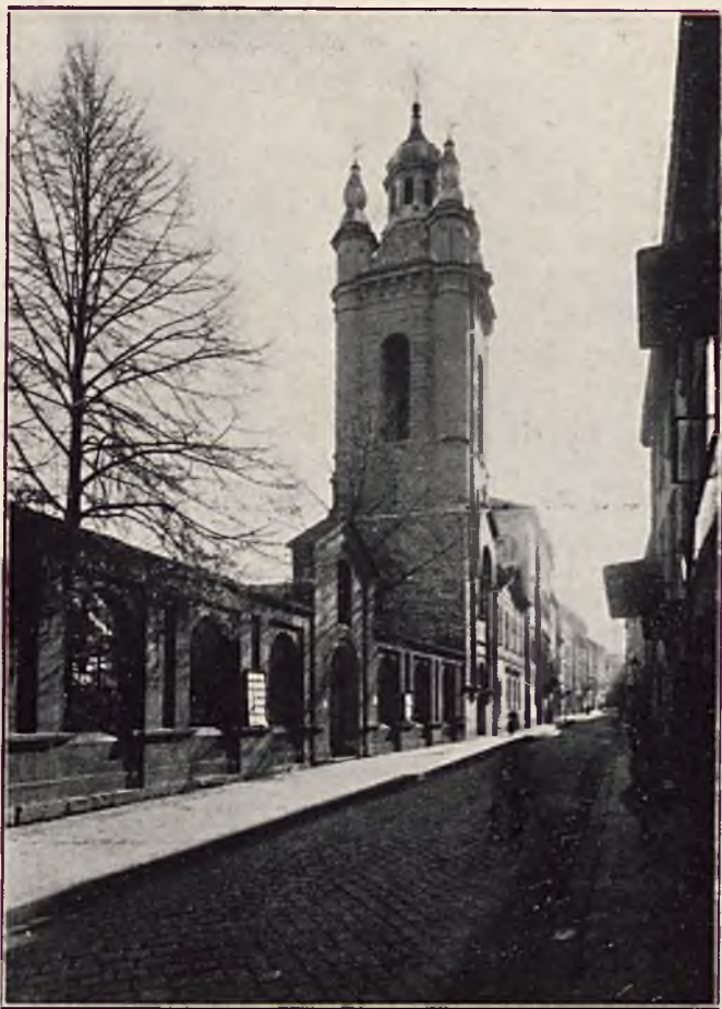
Mur cmentarny i wieża od ul. Ormiańskiej w. XVI—XIX.
