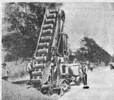
Rys. 1. Podnośnik kubelkowy ładujący piasek do wózka silnikowego.
