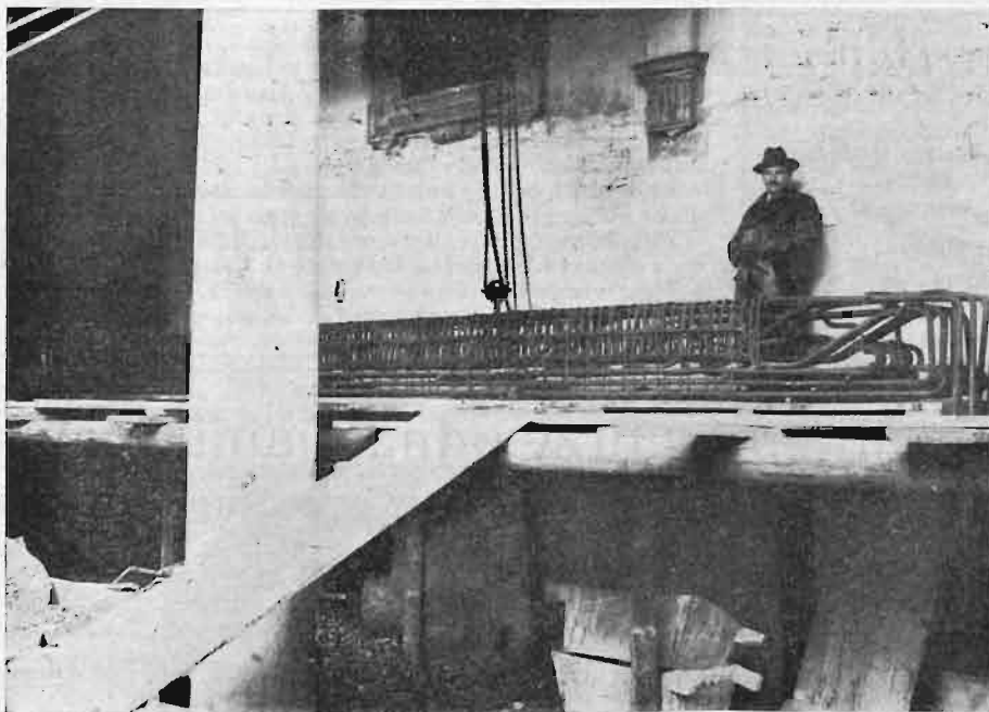
Rys. 3. Szkielet żelazny jednej z belek B przed wsunięciem na miejsce przeznaczenia.
