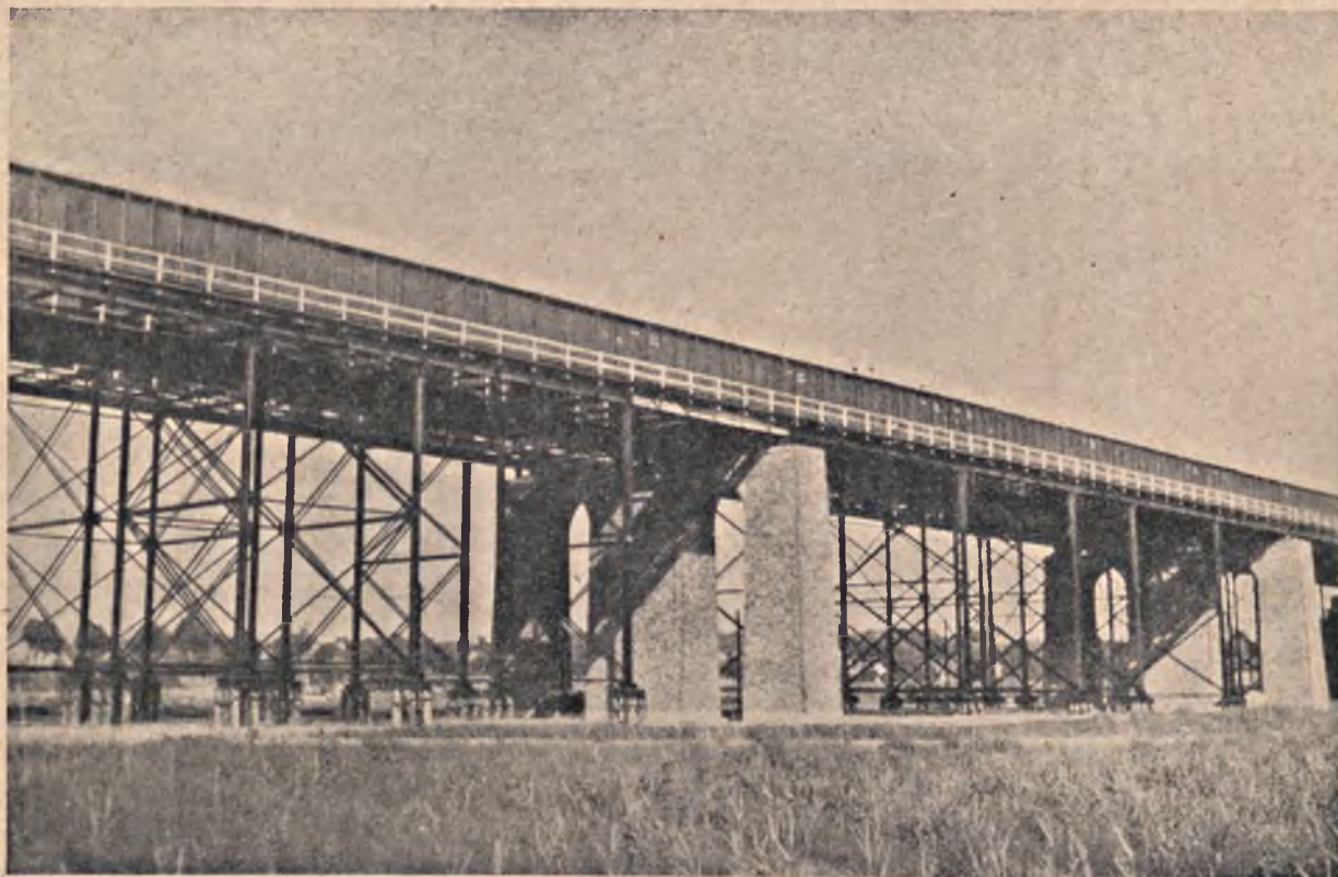
Rys. 14. Most pod Kalkbergiem podczas budowy.
