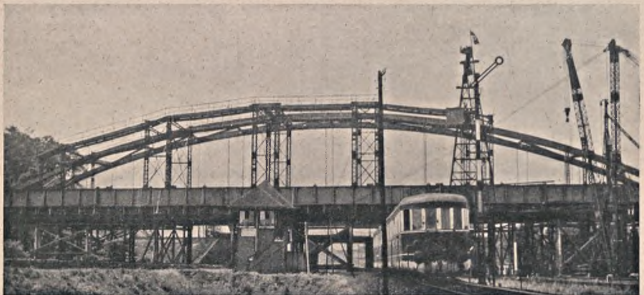
Rys. 17. Most pod Kaiserbergiem podczas montowania.
