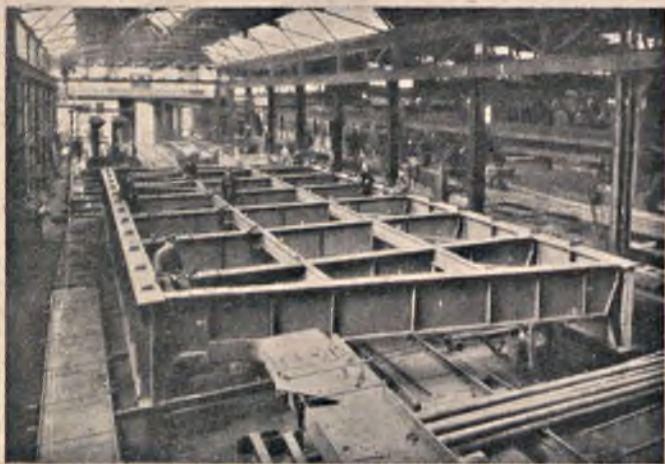
Rys. 22. Most spawany złożony w warsztacie.
