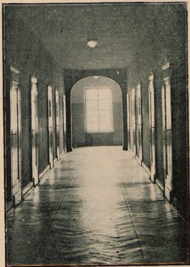
Korytarz w Domu Akademickim w Warszawie przy ul. Grójeckiej.
