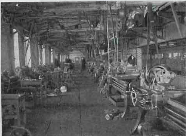
Rys. 3. Galeria w hali maszynowej.
