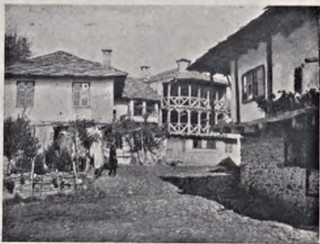
Fig. 86. — Construction en bois à Gabrovo
