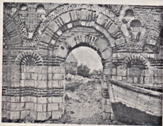
Fig. 104. — Détail de l'église St. Jean à Messemvria (XIV s.)
