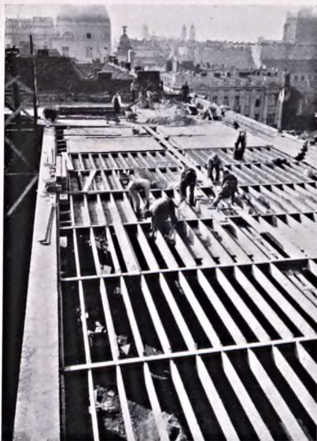
UKŁADANIE STROPÓW
