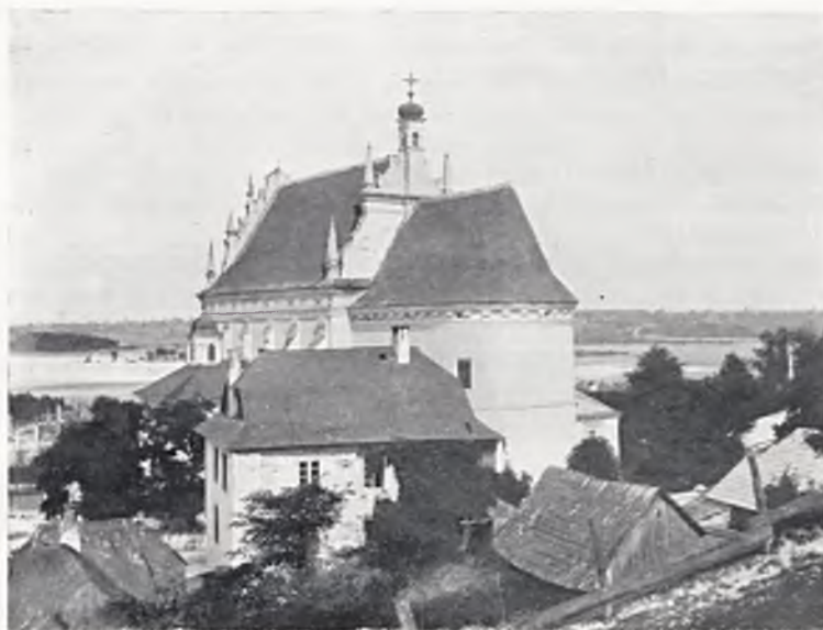
KOŚCIÓŁ FARNY (widok od strony połudn.-wschod.) W KAZIMIERZU NAD WISŁĄ (pow. puławski)
