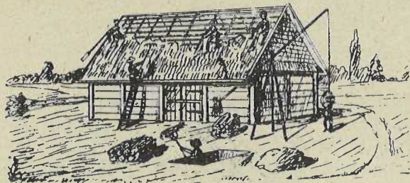
Rya. 57. Robota dachu słomiano-glinianego.
