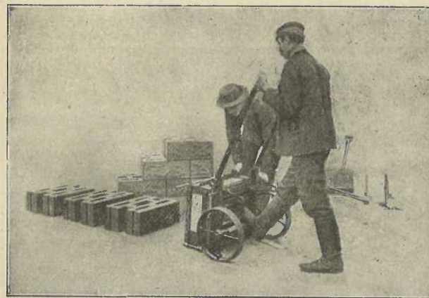
Ryc. 52. Przewracanie formy i opuszczanie w niej pustaka na ziemię.
