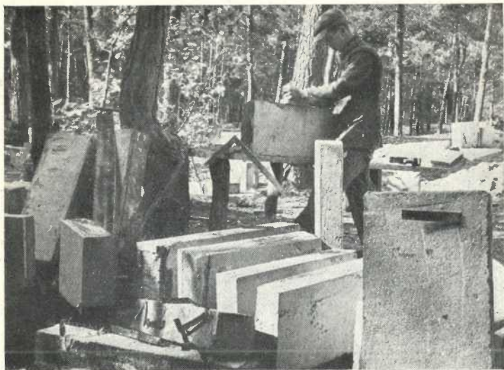
Rys. 16. Obróbka płyt celolitowych, licowanych kamieniem pińczowskim. (Patent inż. Cz. Pukińskiego).
