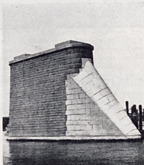
Filar rzeczny mostu drogowego na Wiśle w Puławach
