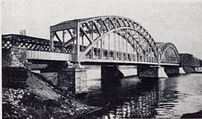
Most kolejowy na Dźwinie w Rydze
