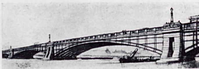
Lambeth Bridge na Tamizie w Londynie
