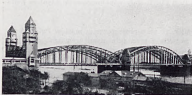
Most kolejowy i drogowy — Nord Brücke — na Renie w Kolonii
