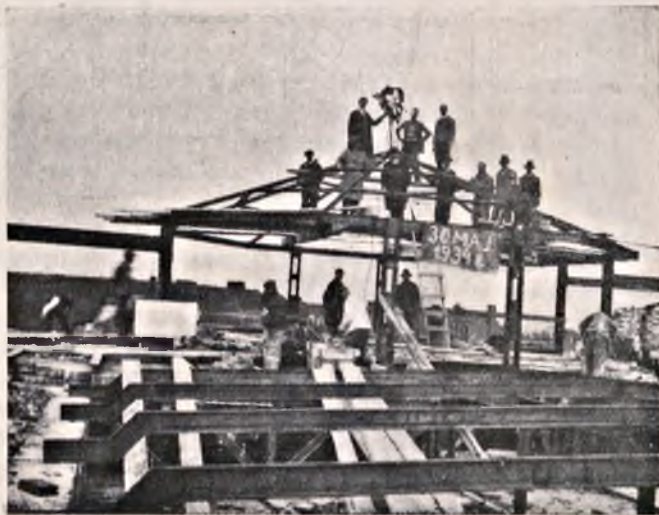
Fig. 12. Krokwie dachowe i świetlik.
