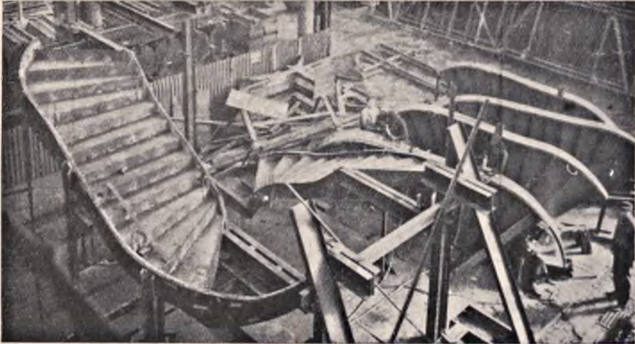
Fig. 18. Schody podczas wykonywania w warsztatach Zakładów Ostrowieckich.
