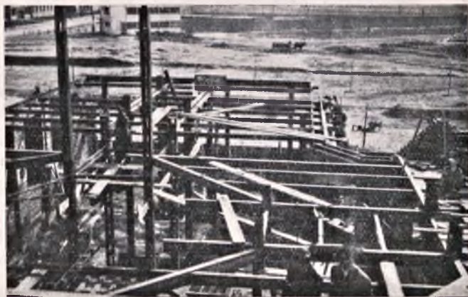
Fig. 2. Ukośne podciągi stropowe.
