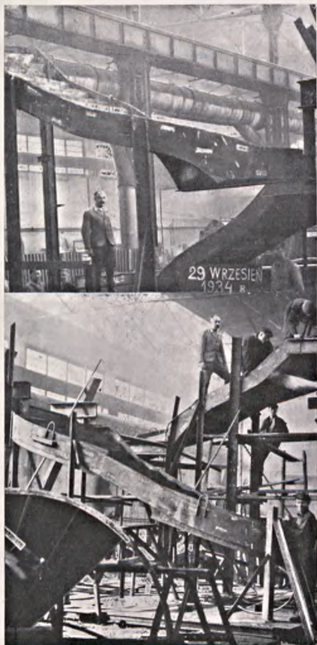
Fig. 16 i 17. Schody podczas wykonywania w warsztatach Zakładów Ostrowieckich.
