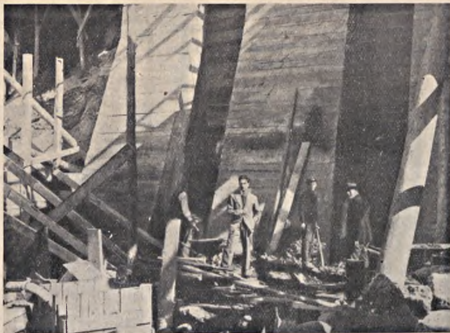
Fig. 22. Mur oporowy Centr. Telegr. i Telef. w Warszawie.
