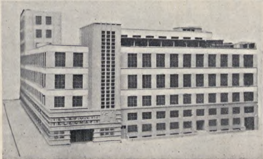
Fig. 19. Gmach Centrali Telegrafów i Telefonów w Warszawie.
