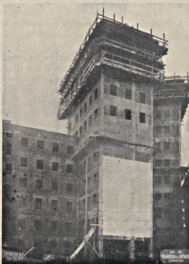
Fig. 5. Budowa Gmachu Powszechnego Zakładu Ubezpieczeń Wzajemnych w Warszawie.
