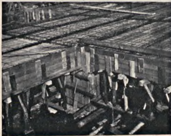
Fig. 18. Strop suterenu gmachu w Katowicach.
