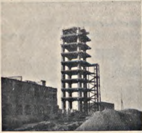
Fig. 12. Szkielet żelbetowy wieży ciśień na Okęciu.
