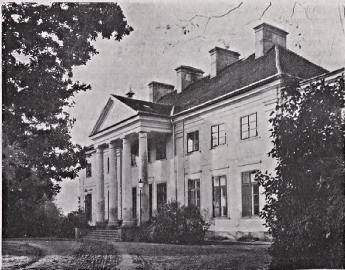
DWÓR W MCHACH. Widok od zajazdu.
