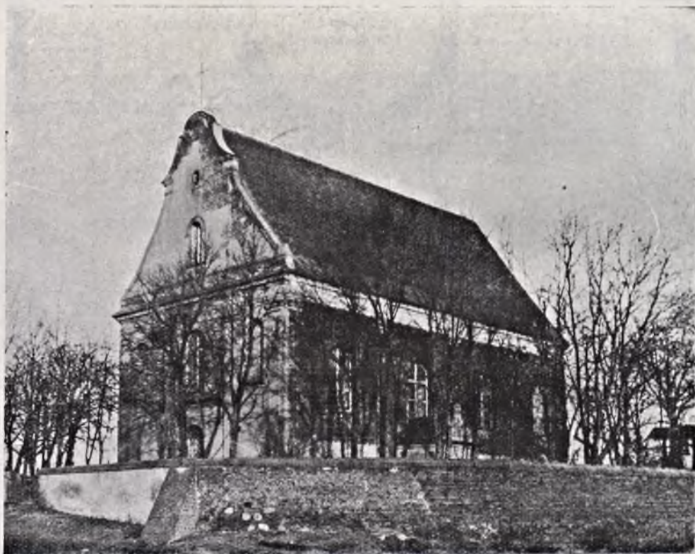
KOŚCIÓŁ W WĄWELNIE. Widok od strony wejścia.
