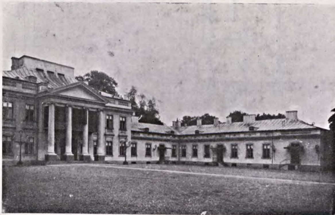
PAŁAC BELWEDERSKI W WARSZAWIE. Widok od zajazdu.
