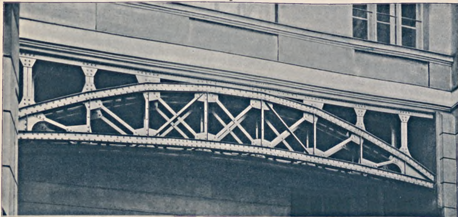
Rys. 14. Dźwigar pod murem zewnętrznym klatki schodowej.
