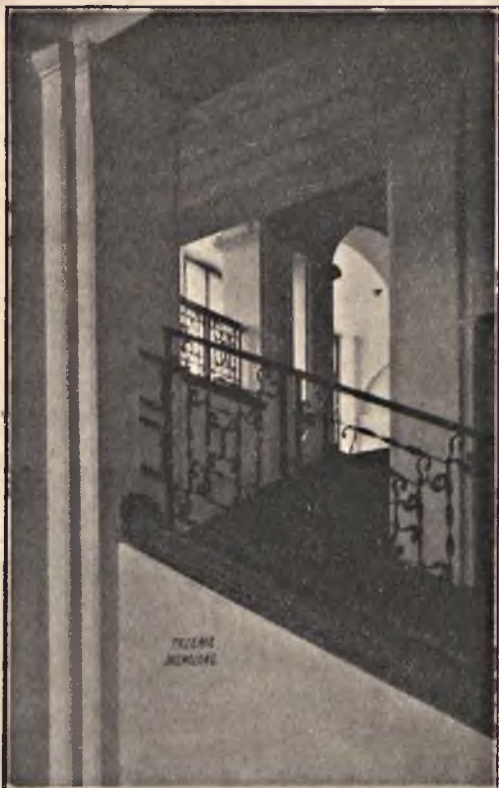
Schody z parteru na I piętro.
