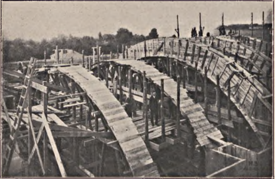
Deskowania do wiązarów żelbetonowych nad aulą.
