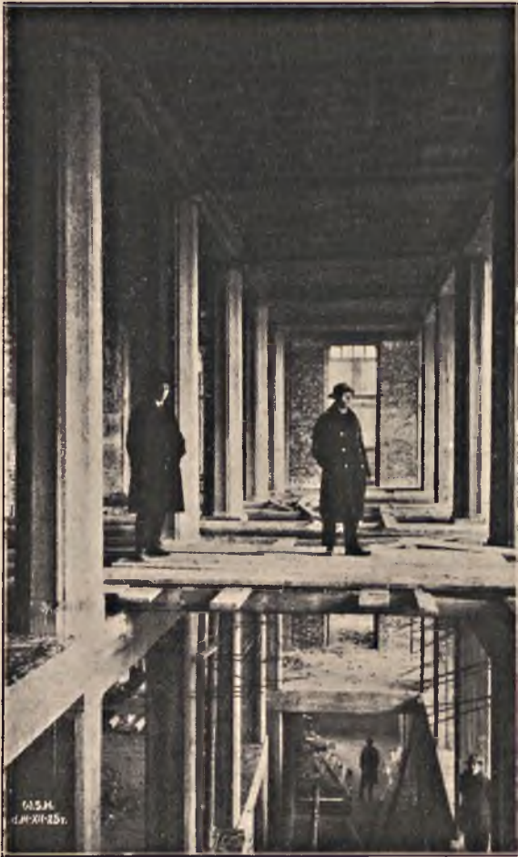
Widok wnętrza w surowym stanie przez wszystkie piętra.
