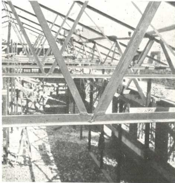
Rys. 5. Widok z bliska połączenia wpustowego słupka i połączenia stykowego krzyżulca z pasem.
