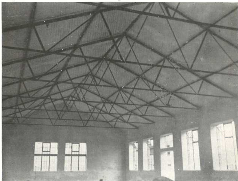
Rys. 1. Widok na całość konstrukcji dachowej po wykonaniu.
