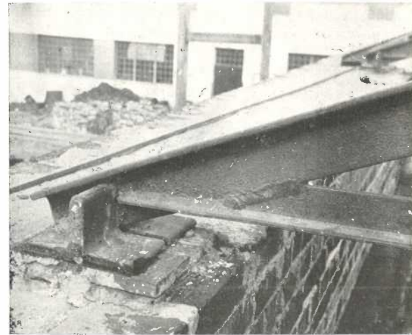
Rys. 6. Węzeł podporowy więzara.
