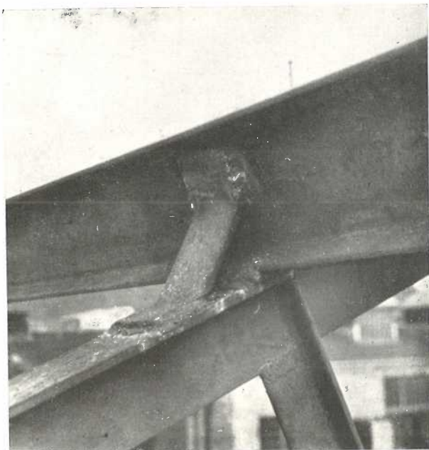
Rys. 9. Umocowanie płatwi na więzarach.
