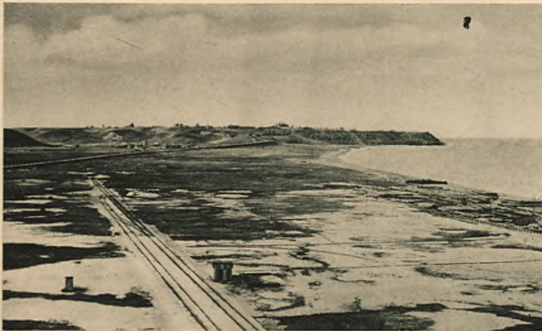
PIERWSZA LINJA KOLEJOWA NA TERENIE PRZYSZŁEGO PORTU. WIDOK NA KĘPĘ OKSYWSKĄ.
