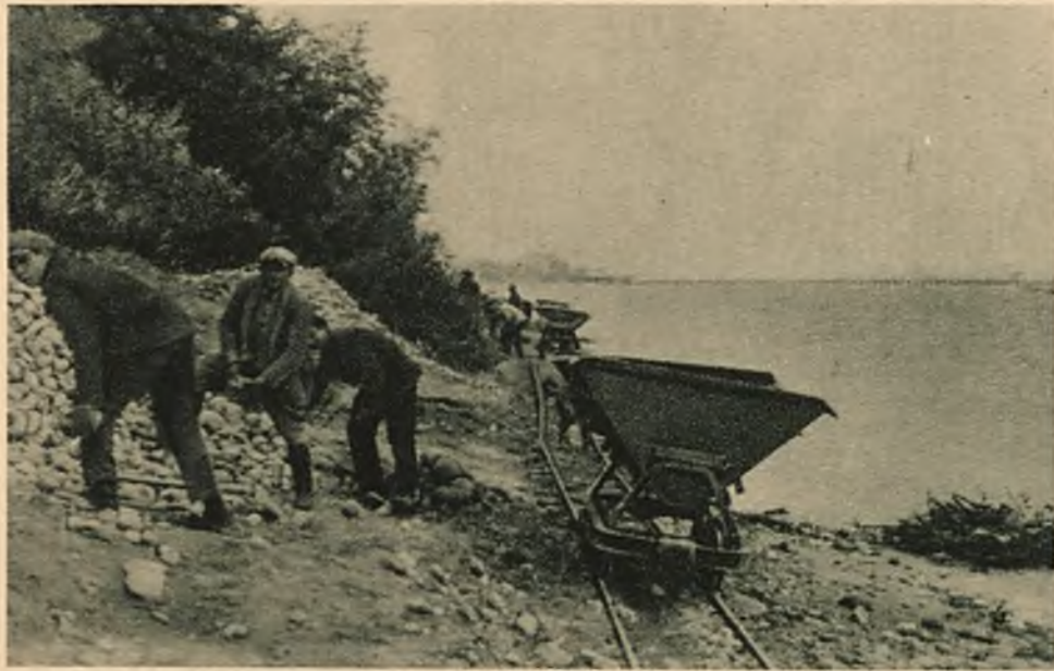
REGULACJA OSYPUJĄCEGO SIĘ BRZEGU.
