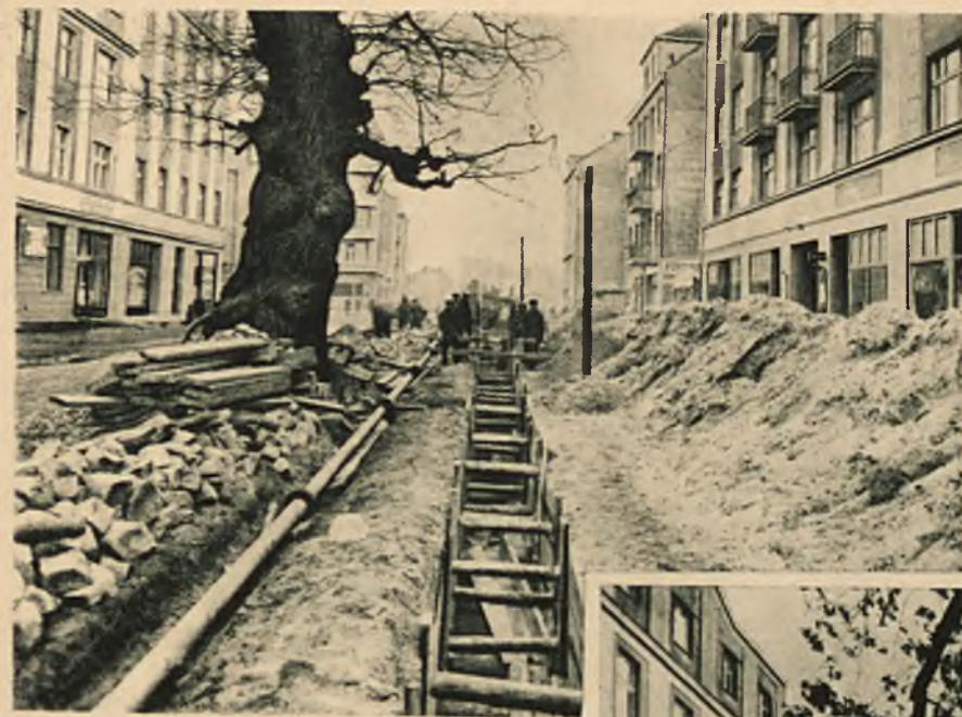
ZAKŁADANIE KANALIZACJI NA UL. PORTOWEJ.
