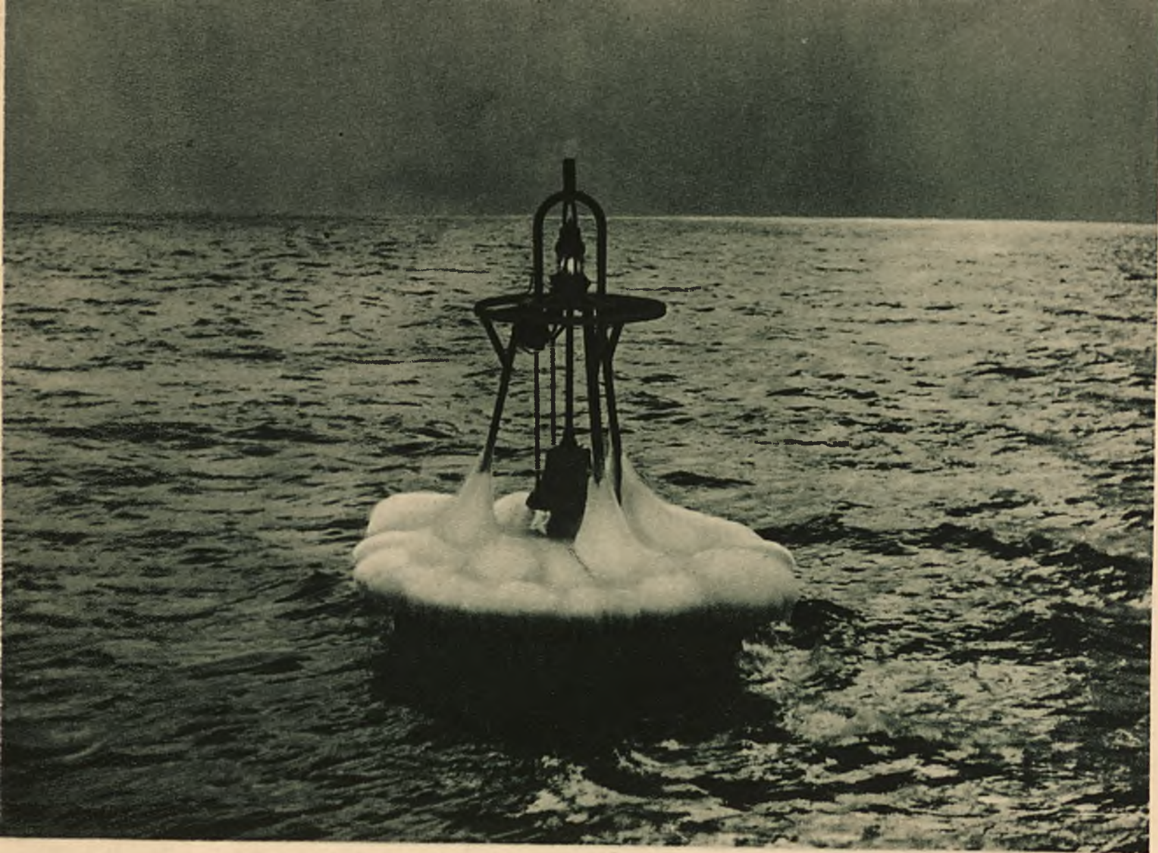
OBMARZNIĘTA BOJA WJAZDOWA PORTU GDYNSKIEGO.
