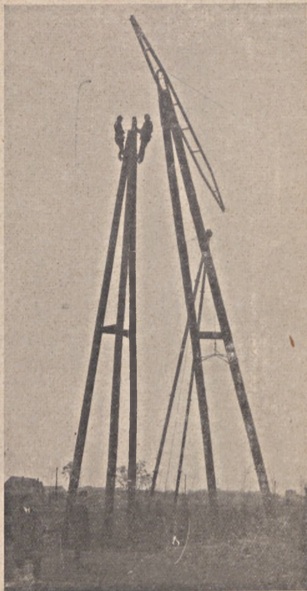
Rys. 23 Ciężki montaż słupa narożno-odciągowego systemu portalowego. 60/110 kV, 3 \times 35 Cu. Linja Gródek — Toruń, 1927.
