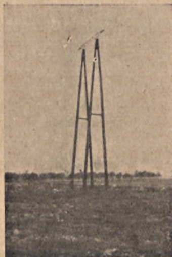
Rys. 21. Portalowy słup podporowy, składający się z 2 słupów rozkracznych po 18 m długości. Odległość międzyprzewodowa 2 \times 3,5 m. Przęsła 250 (maks. 280) m. Linja Gródek — Gdynia, 1928.
