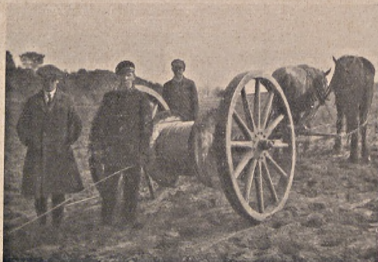
Rys. 24 Rozwojenie linki końmi i wozem 1-osiowym („armatą”). Linja Gródek — Grudziądz, 1925.
