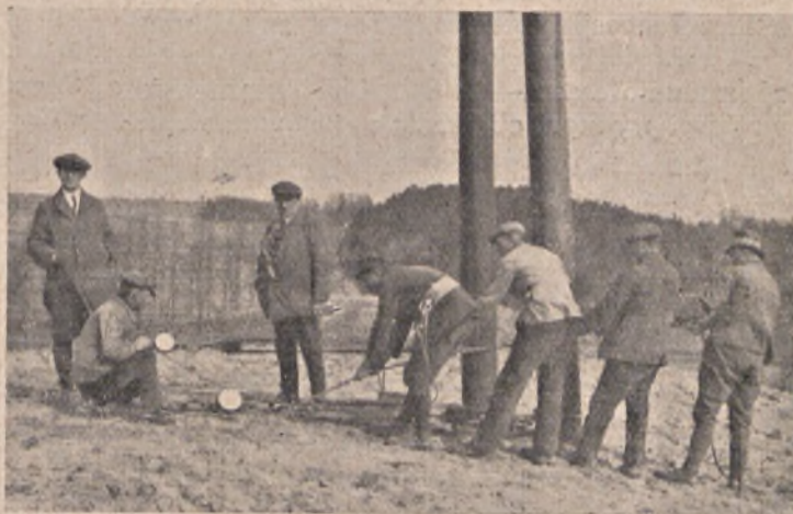
Rys. 25. Naciąganie przewodów za pomocą wielokrążków i dynamometrów, 1925.
