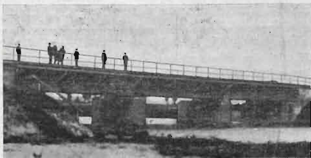
Rys. 2. Most żelbetowy na rzece Ochni.
