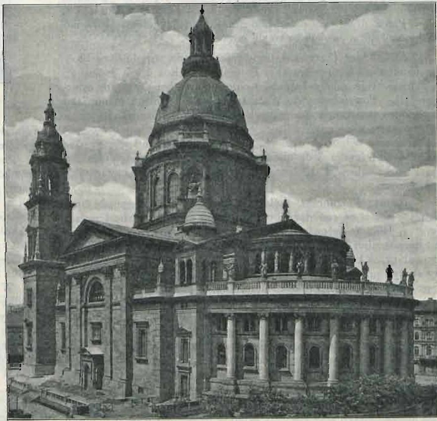
Rys. 3. Widok od strony presbiterium.
