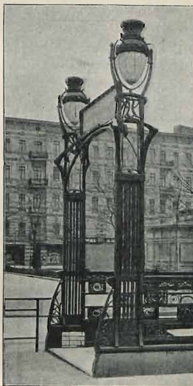
Rys. 6 Wejście do dworca drogi żelaznej podziemnej w Berlinie. Arch. prof. A. Grenander w Berlinie.
