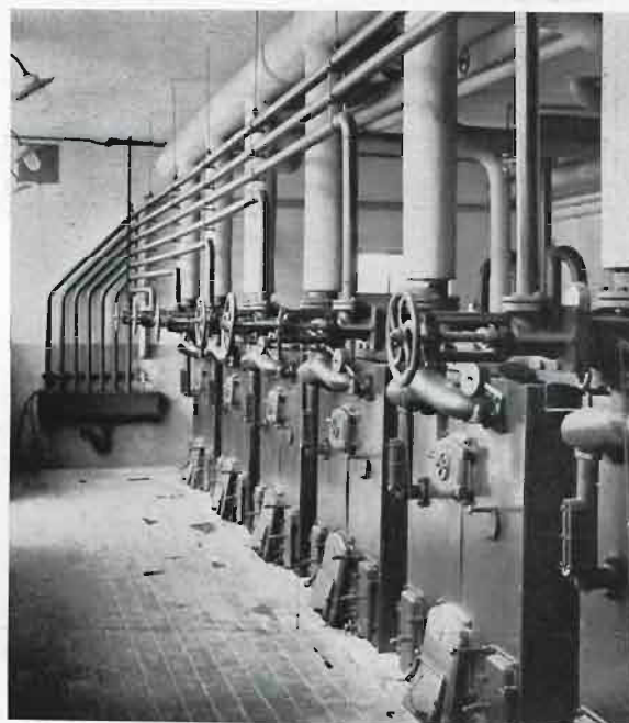
Kotły C. O. i tablica rozdzielcza.
