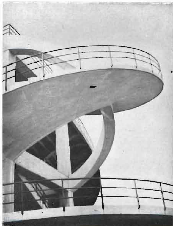
Schody zewnętrzne. Stadion. Florencja.
