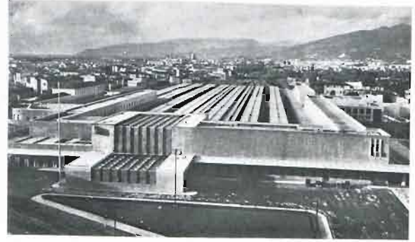
Arch. arch. N. Baroni, P. N. Berardi, I. Gambellini, S. Guornieri, L. Lusanna, G. Michelucci. — Dworzec. Florencja.
