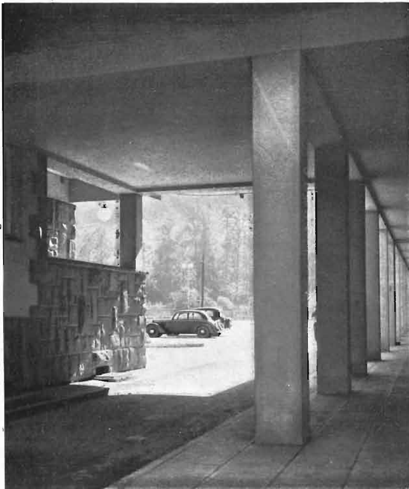
Widok z przejazdu i podcieni.
