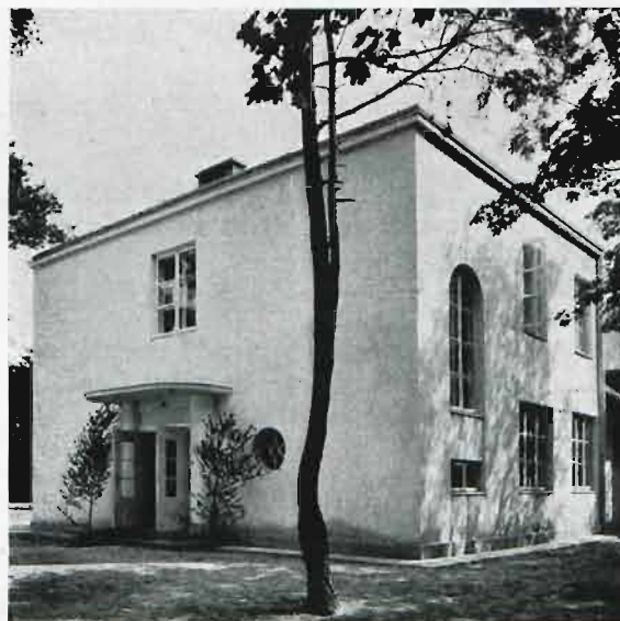
Rozbudowa Zakładu św. Józefa w Otwocku.
