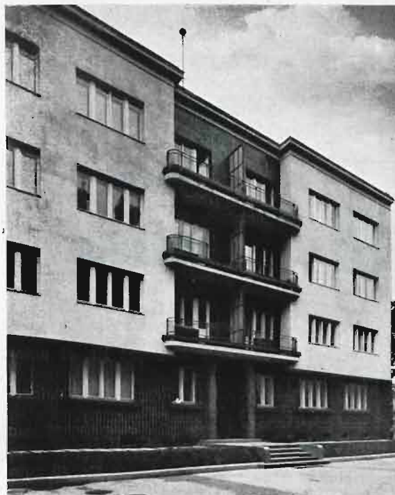
Dom mieszkalny na Mokotowie.
