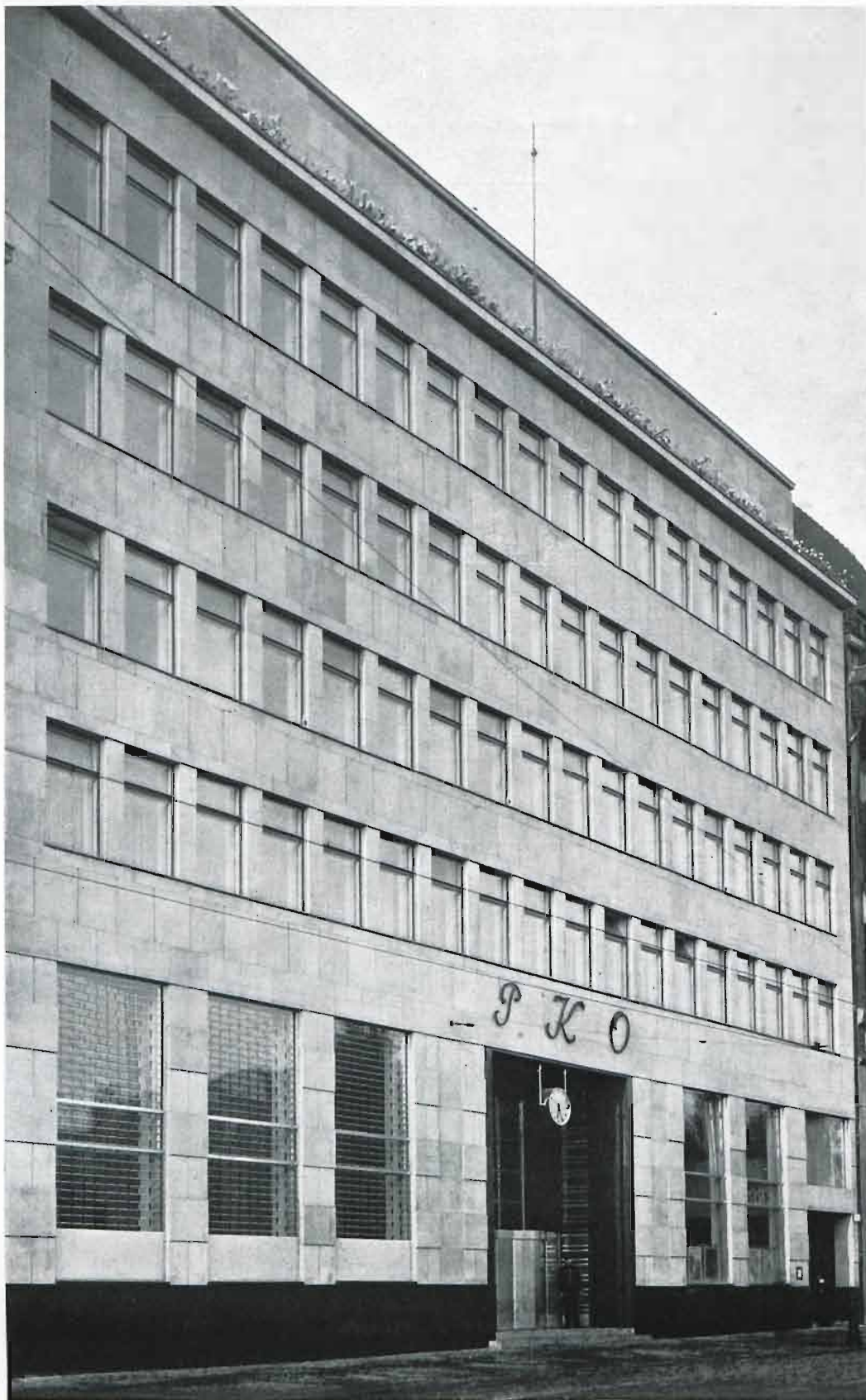
Elewacja frontowa od Placu Wolności.
