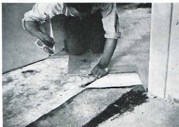
Układanie podłóg na stropach.
