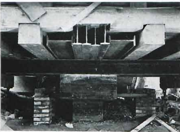
Próba obciążenia pala.
