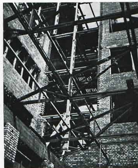
Fragment konstrukcji świetlika nad salą kasową.
