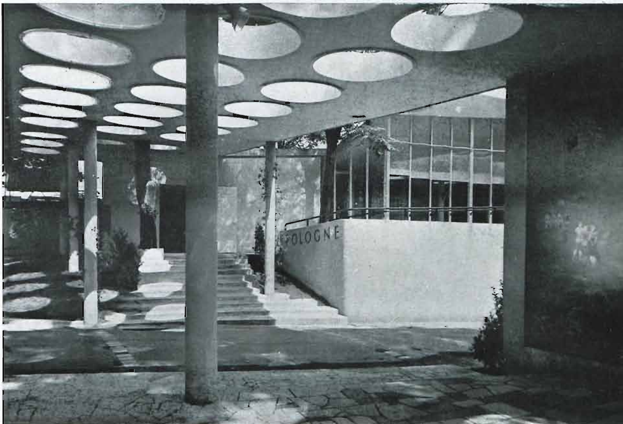
Przejsie do pawilonu gospodarczego.
