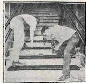
Rys. 3. Mocowanie okładzin schodowych.
