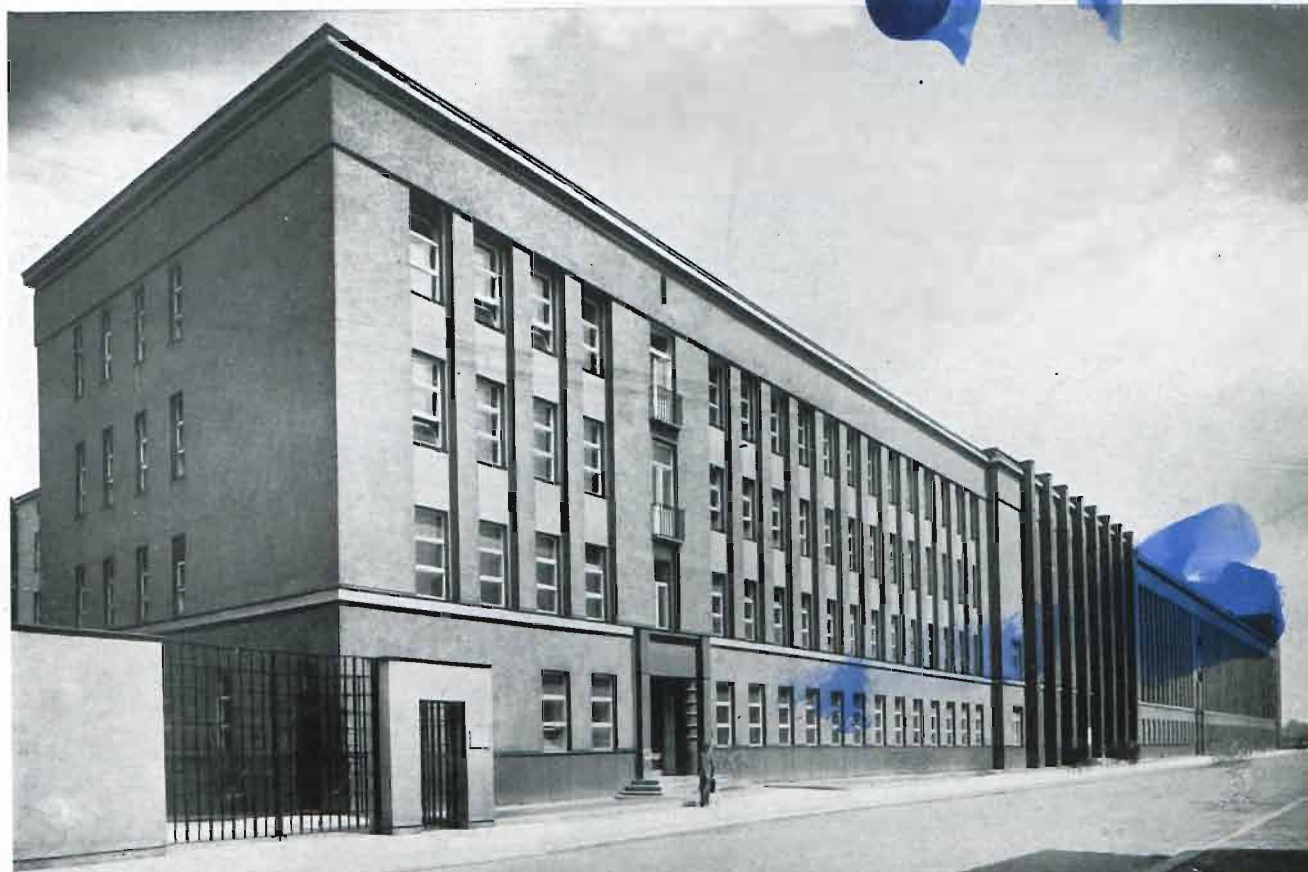
ARCH. JADWIGA DOBRZYŃSKA (SARP), ARCH. ZYGMUNT ŁOBODA (SARP). fot. Photo-Plat. Śląskie Techniczne Zakłady Naukowe — Instituts Scientifiques Techniques de Silésie. KATOWICE
