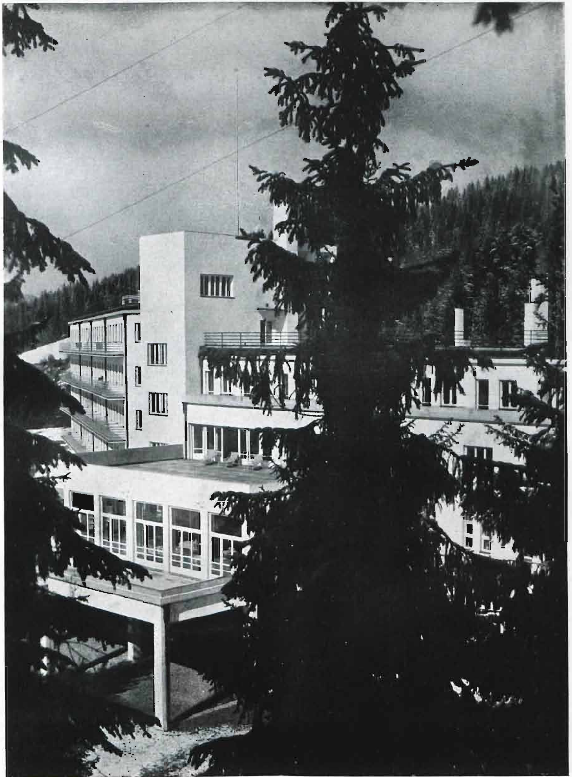
ARCH. WŁADYSŁAW ŚWIRCZEWSKI. Dom wypoczynkowy „Rodziny Kolejowej” — Maison de repos des fonctionnaires des chemins de fer de l'Etat. MAKÓW PODHALAŃSKI
