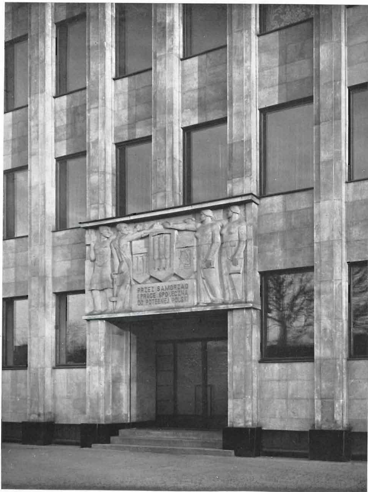
Arch. arch. Bohdan Krzemieniewski i Leon Marek Suzin. Fot. E. Koch. Dom Związku Pracowników Samorządu Terytorialnego Rzplitej Polskiej w Warszawie. Fragment elewacji.
