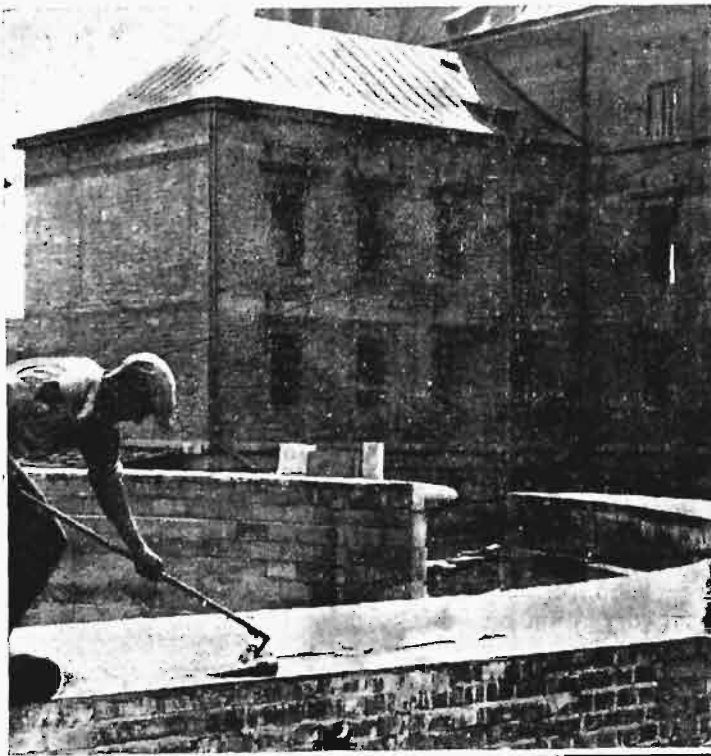
Izolacja pozioma murów Katedry Śląskiej w Katowicach
