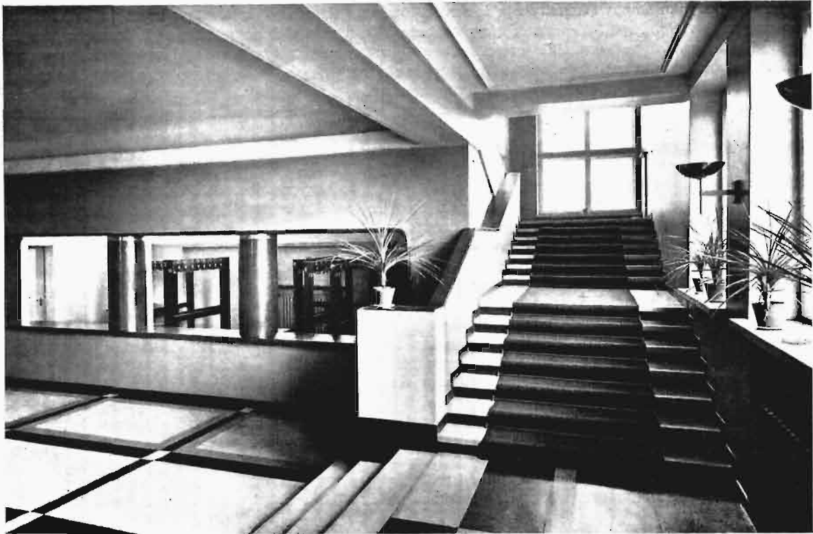
DOM MEDYKÓW. HALL I SCHODY NA PIĘTRO. ARCH. STANISŁAW ODYNYEC-DOBROWOLSKI.
