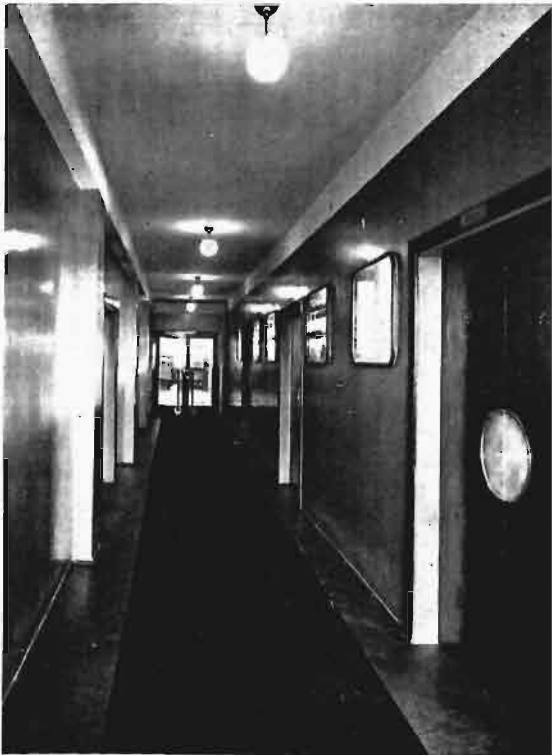
KORYTARZ NA PARTERZE.
